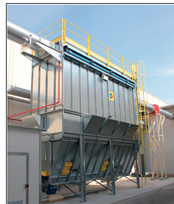
Impianto di aspirazione e filtrazione polveri (MVT - Mion Ventoltermica)
