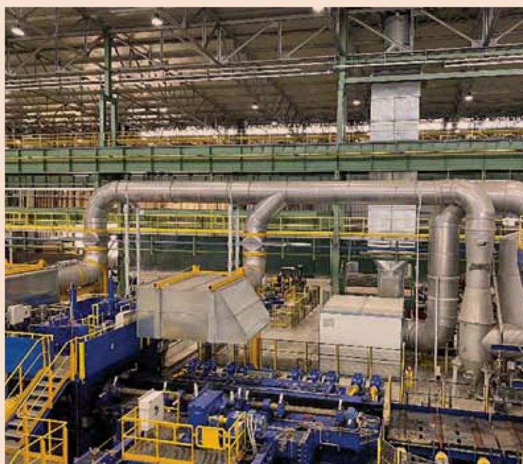
Sistema avanzato di aspirazione laminazione acciaio realizzato per il leader europeo Dufferco Travi e Profilati
